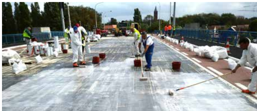
Het rijoppervlak werd geprimed met POLYAC®14 en de stalen oppervlakken met POLYAC®15.
