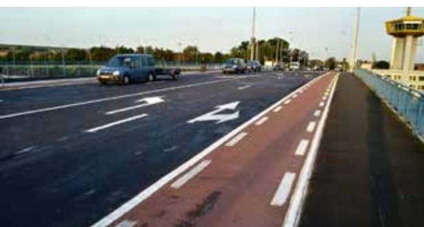
Tot slot werd de oppervlakte afgewerkt met een zwarte POLYAC®61-toplaag.
