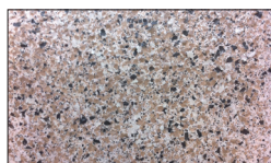
Finition avec paillettes saupoudrées à refus et une couche de finition transparente.
